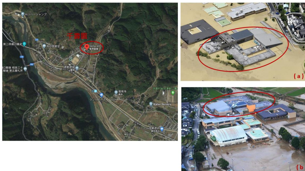
圖 9、球磨村千壽園受災情形：(a) 災時、(b) 7 月 4 日傍晚(資料來源：Google 底圖、(a)共同社、(b)法新社；災防科技中心編修) [18][17]
