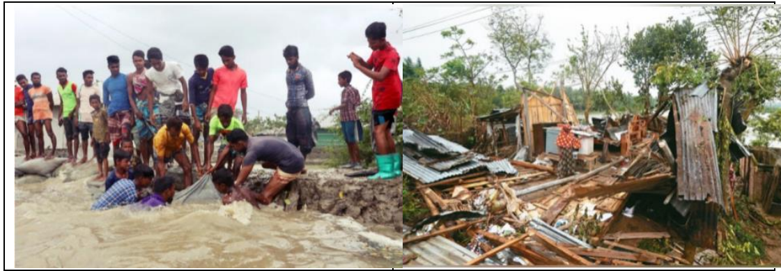
圖 9、安攀氣旋侵襲印度東北部，造成多處淹水及大量建築倒塌。 (照片來源：路透社/法新社)
