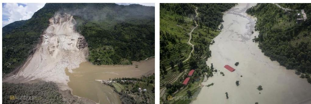
圖 9 崩塌的大量土石所造成之堰塞湖
