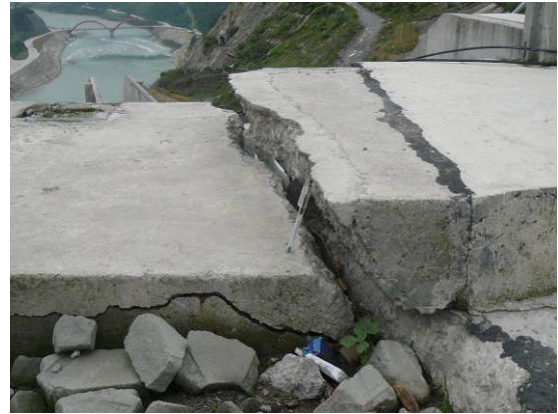
照片 2 水庫壩頂受地震影響，照片左側相對右側陷落約 15 公分。
