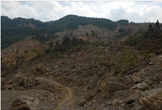
照片 25 滑坡體並未完全潰散，部份植生仍豎立於坡體上。
