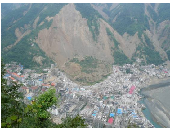
照片 33 王家岩地滑掩埋舊北川縣城。王家岩地滑區地質為板岩、千枚岩、及變質砂岩等；本地滑原本就是一老(舊)地滑。
