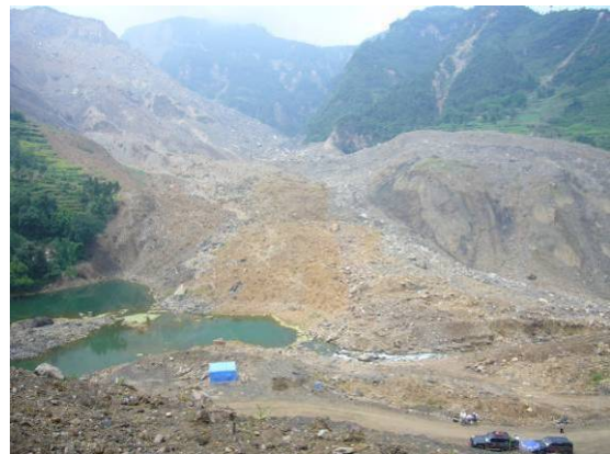
照片 20 照片左側水潭為東河口村崩塌堵塞紅石河形成之堰塞湖，照片中之水面為開挖洩洪管道後之水位。
