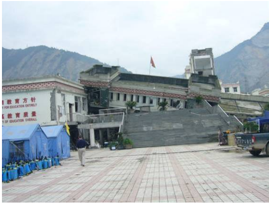
照片 15 映秀鎮漩口中學於地震時校舍倒塌，後方映秀小學則全毀，造成重大傷亡。
