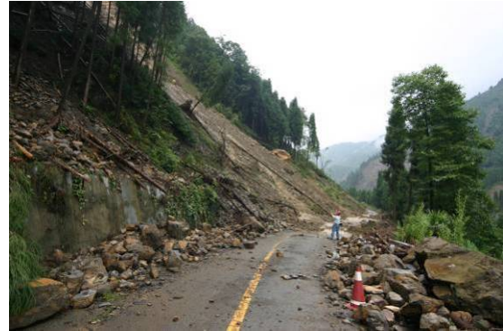
照片 52 於現地調查最後一天，因前晚及當天有下雨，謝家店子堰塞湖旁公路的上邊坡持續發生滑坡及落石，造成道路中斷而無法繼續向前，為本次汶川地震現地調查的最後一站。
