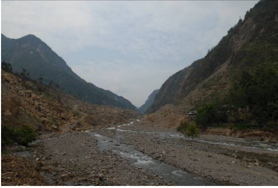
照片 23 由青竹江下游往上游眺望石板溝堰塞壩體，此天然壩體已經開炸引流洩洪。
