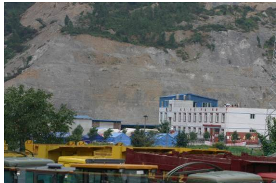
照片 30 地滑將危及坡趾處許多房舍與公共設施之安全。
