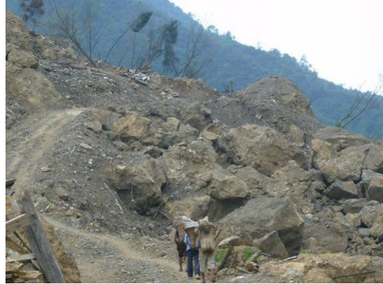
照片 24 石板溝地滑岩層屬板岩夾變質砂岩。
