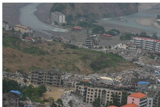
照片 34 王家岩地滑掩埋舊北川縣城約 1600 人，以及湍江曲山段經唐家山堰塞湖洩流後淤積掩埋河岸房舍情形。
