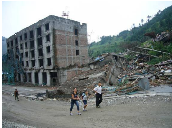
照片 18 斷層經過處，人所站之處正好是逆衝所造成之爬坡位置，倒塌的建築物是映秀煙草公司，斷層上盤房屋倒塌，樹木傾斜。
