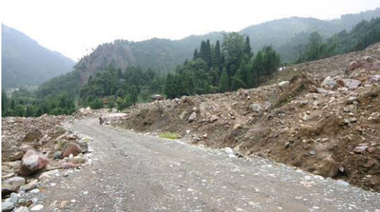
照片 49 龍門山鎮九峰村謝家店遭崩塌土石流
