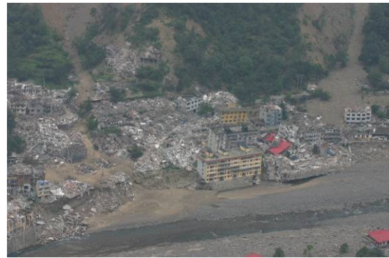
照片 36 曲山鎮因地震而損毀之房屋因土石流再次受災掩埋。
