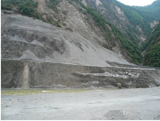
照片 43 堰塞湖潰決過程的渠床沖刷演化歷程。可以看見潰決時的渠床坡度由陡變緩，相對而言，表示潰決開始流量極大，而後逐漸變小。
