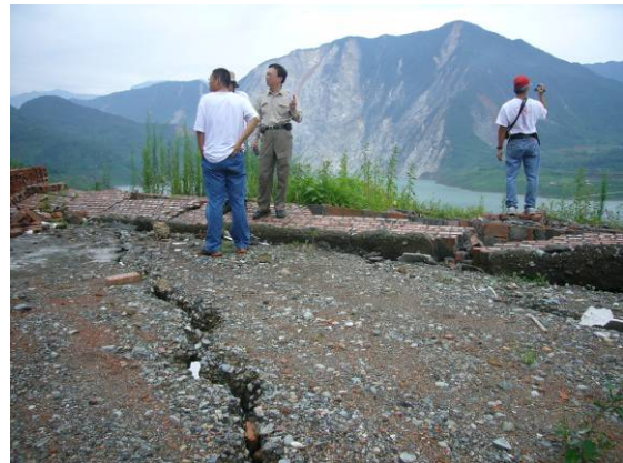
照片 6 紫坪鋪水庫廟子坪附近岷江右岸受地震影響龜裂。
