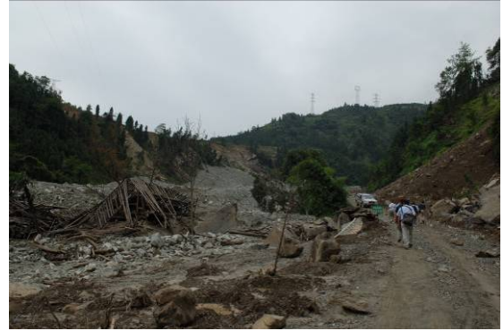
照片 12 牛圈溝河道內為花崗岩碎屑堆積，兩岸為砂岩，照片左側可見原來房舍已遭掩埋。
