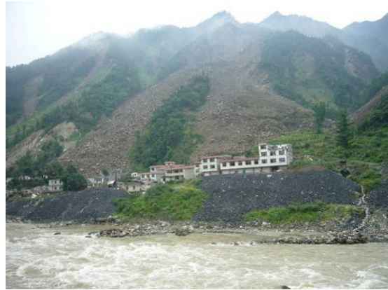
照片 16 岷江左岸河岸邊的棄碴，疑似都汶高速公路龍溪隧道開挖之棄碴(疑是煤礦渣)。
