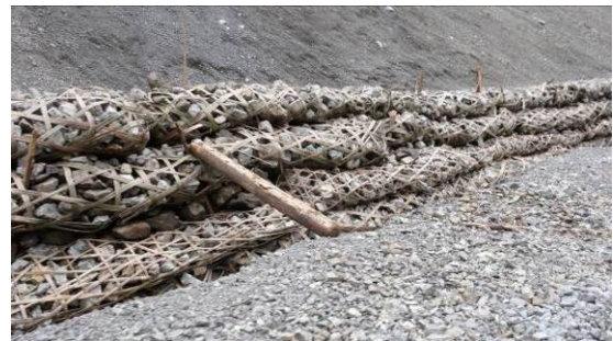
照片 42 肖家橋堰塞湖開挖排洪溝，兩岸以竹編之蛇籠穩定堆積土砂坡腳。
