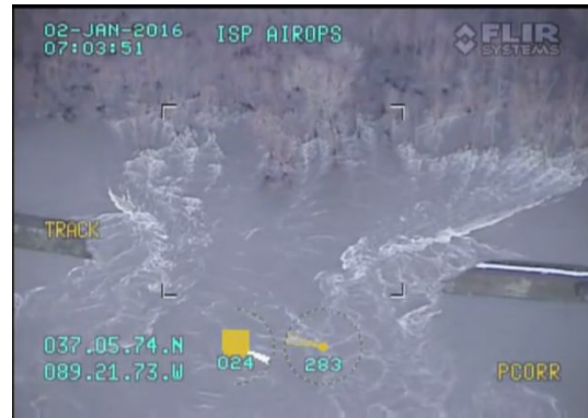
(b) 伊利諾州南邊河堤潰堤
