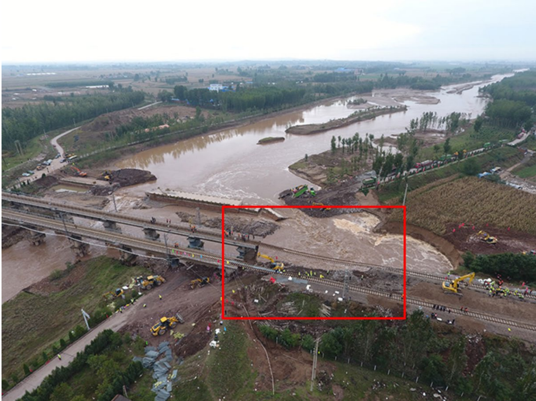
圖 8. 鐵路地基遭淘空，僅剩鐵軌在半空中(紅框處)。(圖片來源：新華社[15])
