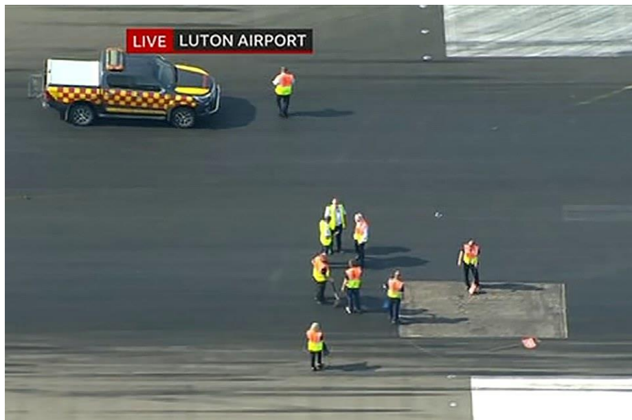
圖 7、盧頓機場跑道因高溫毀損[14]
