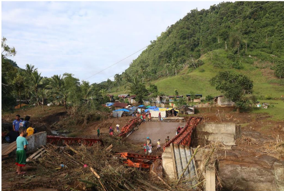
圖6 北拉瑙省(Lanao del Norte) Munai地區橋梁損壞
