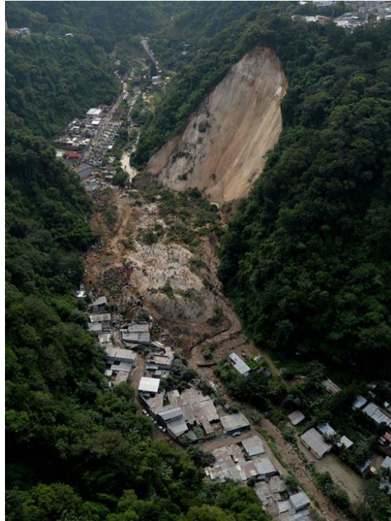
圖 4 康布雷二村南側邊坡山崩
