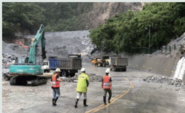
臺9蘇花公路線161.2公里處坍方清運與埋設涵管作業 (資料來源：交通部公路局東區養護工程分局)
