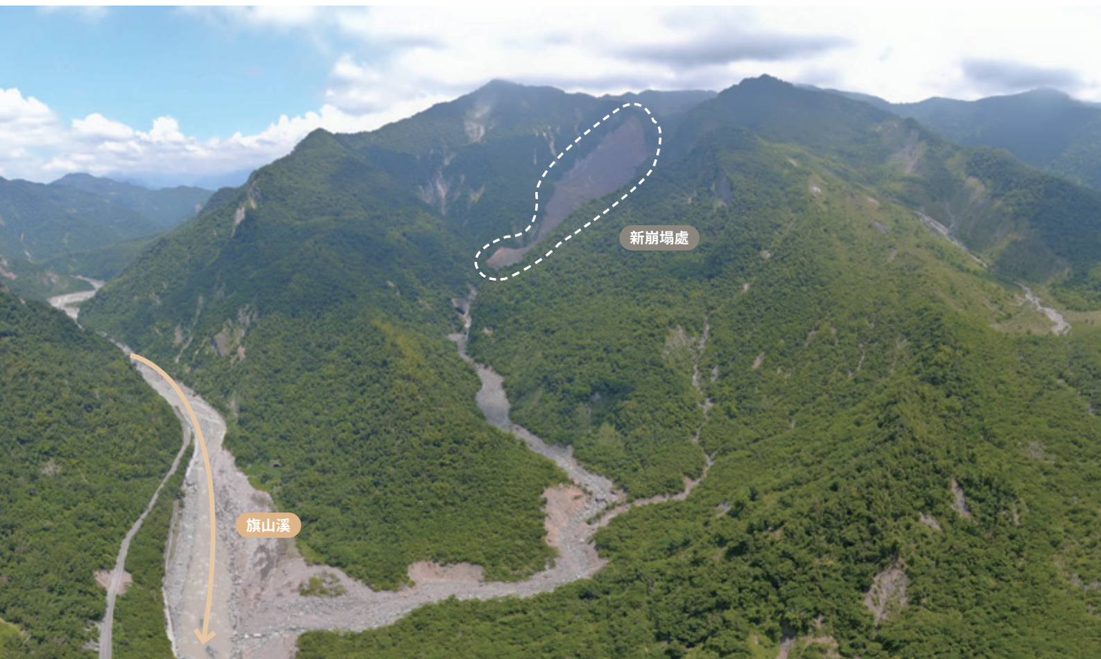
國有林旗山事業區第20林班大規模崩塌調查照片（資料來源：災防科技中心拍攝）
