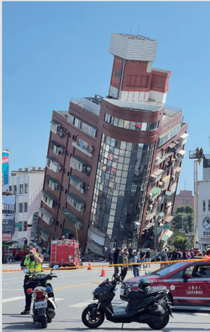
花蓮市區天王星大樓倒塌現場 (資料來源：花蓮縣消防局)
