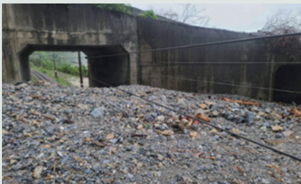
和仁至崇德段的鐵軌遭土石掩埋 (資料來源：國營臺灣鐵路股份有限公司)
