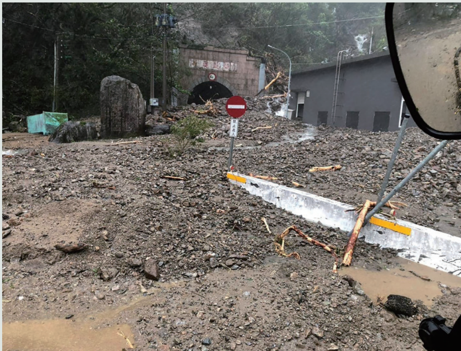
臺灣花蓮縣秀林鄉新澳隧道前土石堆積狀況（資料來源：交通部公路局東區養護工程分局）
