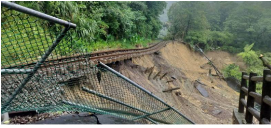
圖 2.3.4、2025 年 10 月 22 日嶺 腳車站鐵路路基淘空狀況(資料 來源：平溪區公所)
