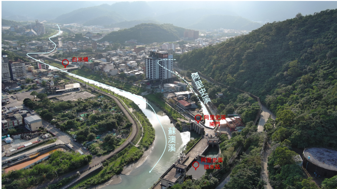
圖 3.3.2、阿里史溪與蘇澳溪匯流處(資料來源：災防科技中心)
