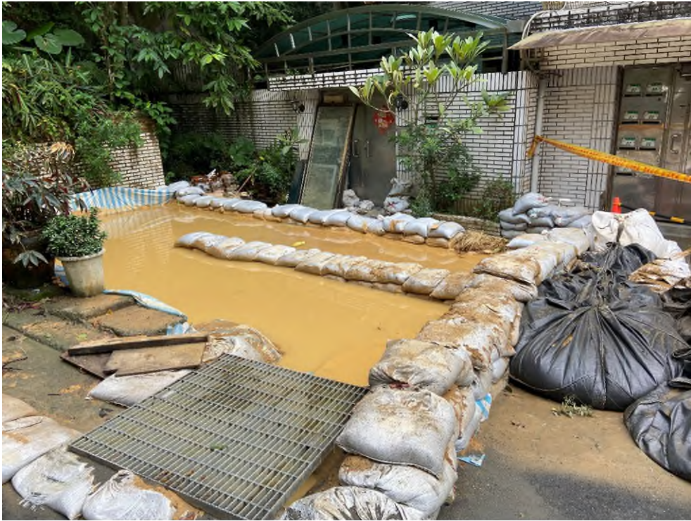
圖 2.3.22、2025 年 10 月 30 日勘災團隊於景華山莊附近拍攝臨時 沉沙池情形(資料來源：災防科技中心)
