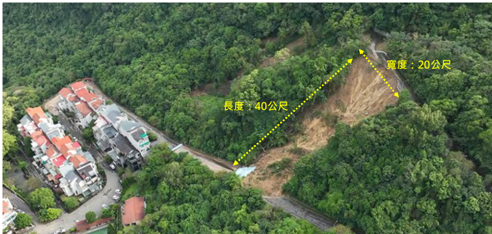
圖 2.3.10、2025 年 10 月 30 日勘災團隊於老爺山莊附近拍攝受災情形(資料來源：災防科技中心)
