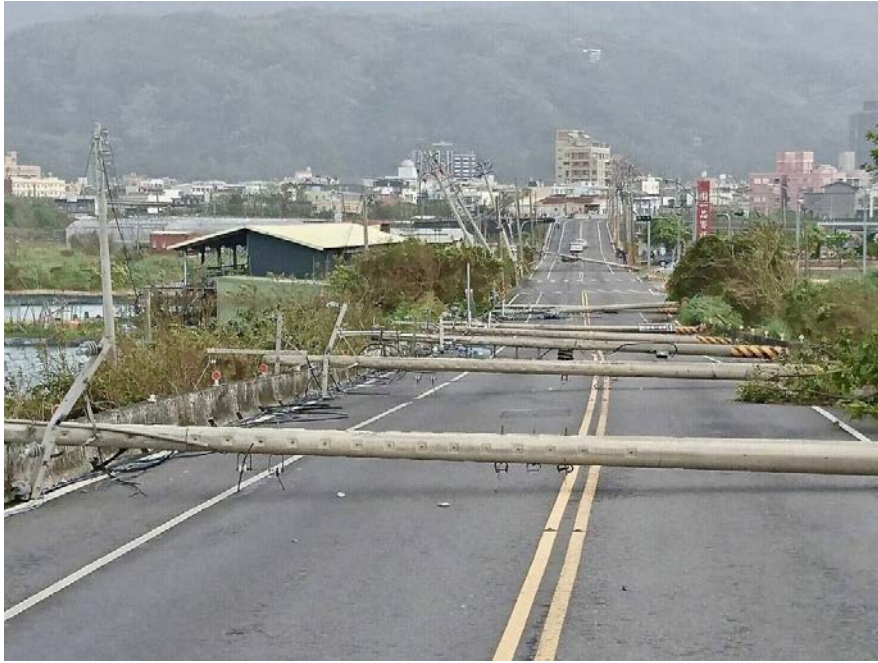
圖 2.18 宜蘭頭城鎮電線桿倒塌情形（資料來源：聯合新聞網）[18]
