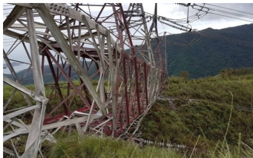
圖 2.19 花蓮民營和平電廠自有輸電鐵塔倒塌（資料來源：聯合新聞網）[19]
