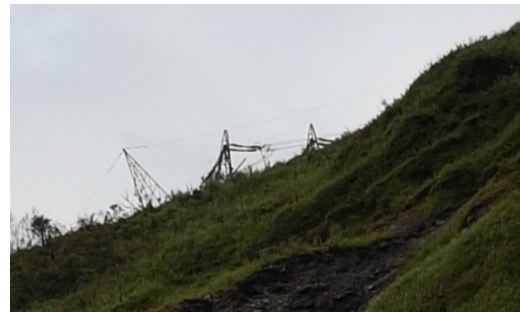
圖 2.19 花蓮民營和平電廠自有輸電鐵塔倒塌（資料來源：聯合新聞網）[19]
