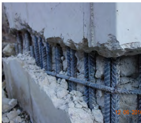
▲ SS685 公路橋梁毀損情形 (資料來源：災防科技中心)
