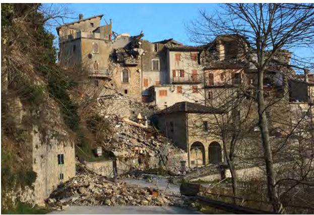
▲ Arquata 大量磚造石造之歷史建物嚴重毀損 (資料來源：災防科技中心)
