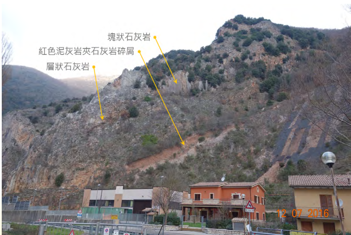
▲ Visso 鎮附近邊坡岩層狀況 (資料來源：災防科技中心)
