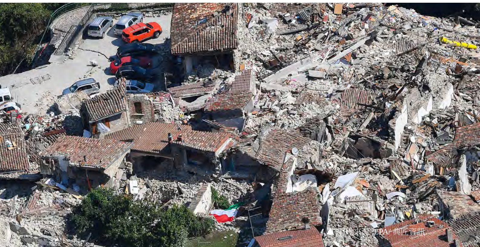
▲ Arquata 大量磚造石造之歷史建物嚴重毀損 (資料來源：災防科技中心)
