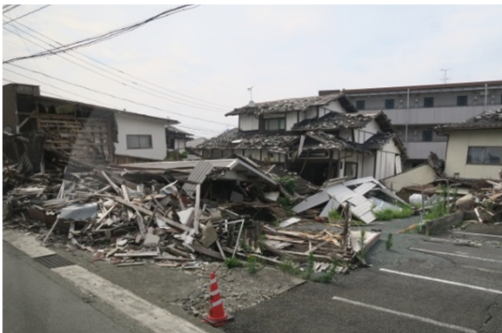
▲ 益城町木造結構建物毀損，因傳統文化與民眾居住習慣之關係，日本住宅仍有大量木造建物，此類建物除因強烈地動造成毀損外，木造結構亦常因屋頂過重導致地震時產生過大水平剪力造成建物毀損（資料來源：災防科技中心）
