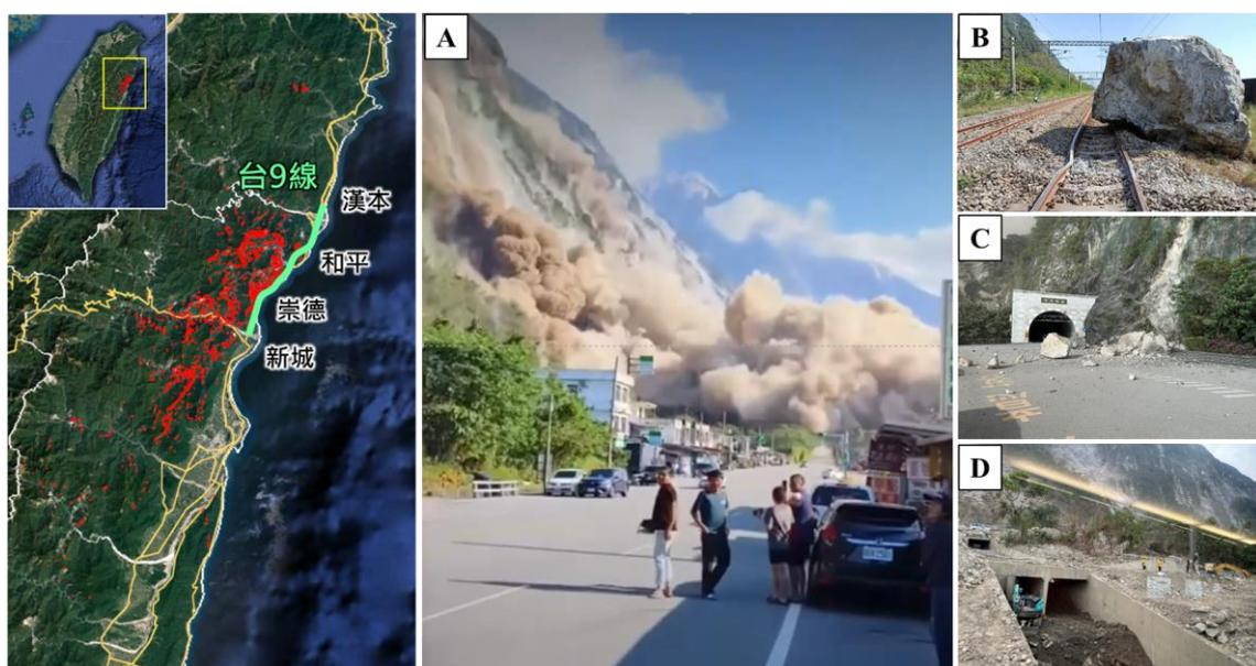
圖 5-12、台 9 線受災狀況。左側地圖之紅色區域為農業部農村發展及水土保持署之 0403 花蓮地震崩塌判釋成果。A 圖：和平地區在主震後民眾拍攝之大量山崩造成大規模揚塵。B 圖：漢本至和平間的台鐵鐵軌被落石阻斷。C 圖：崇德隧道口被落石阻斷。D 圖：主震 4 個月後（2024 年 08 月 05 日），崇德地區仍然有大量的落石與崩塌碎屑堆積於公路與鐵軌旁，清理作業持續進行中。（資料來源：公民回報、農業部農村發展及水土保持署。D 圖由楊清淵拍攝）
