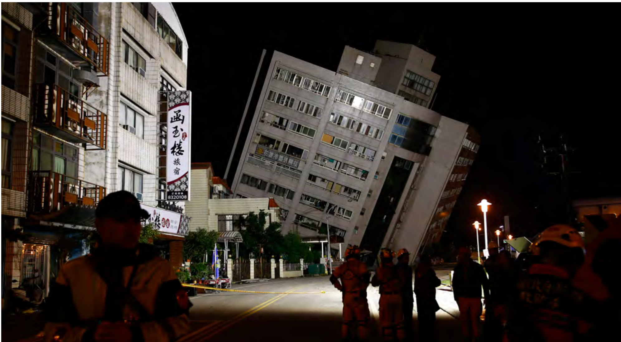
花蓮地震造成市區雲門翠堤大樓房屋嚴重傾斜 (資料來源：歐新社 / 典匠資訊)
