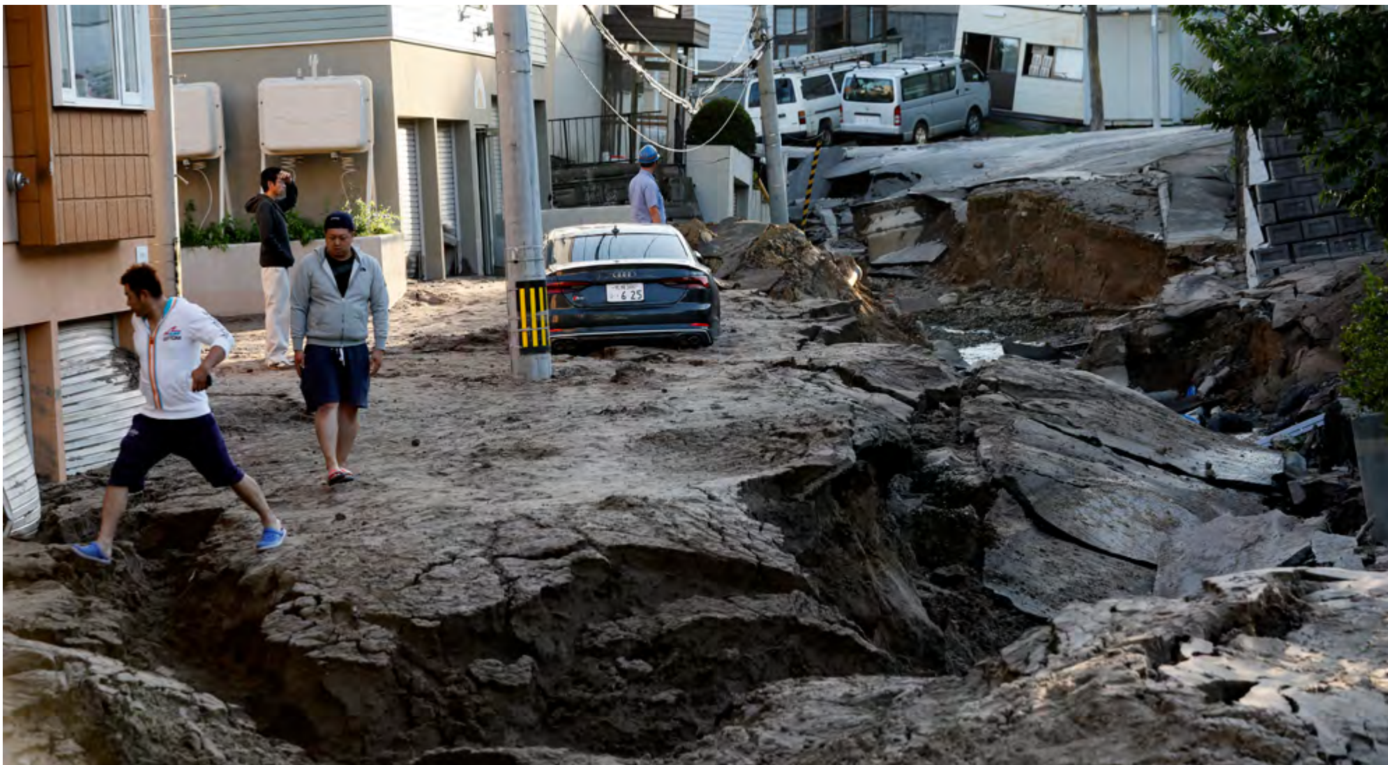
日本北海道地震誘發市區土壤液化情形（資料來源：歐新社 / 典匠資訊）
