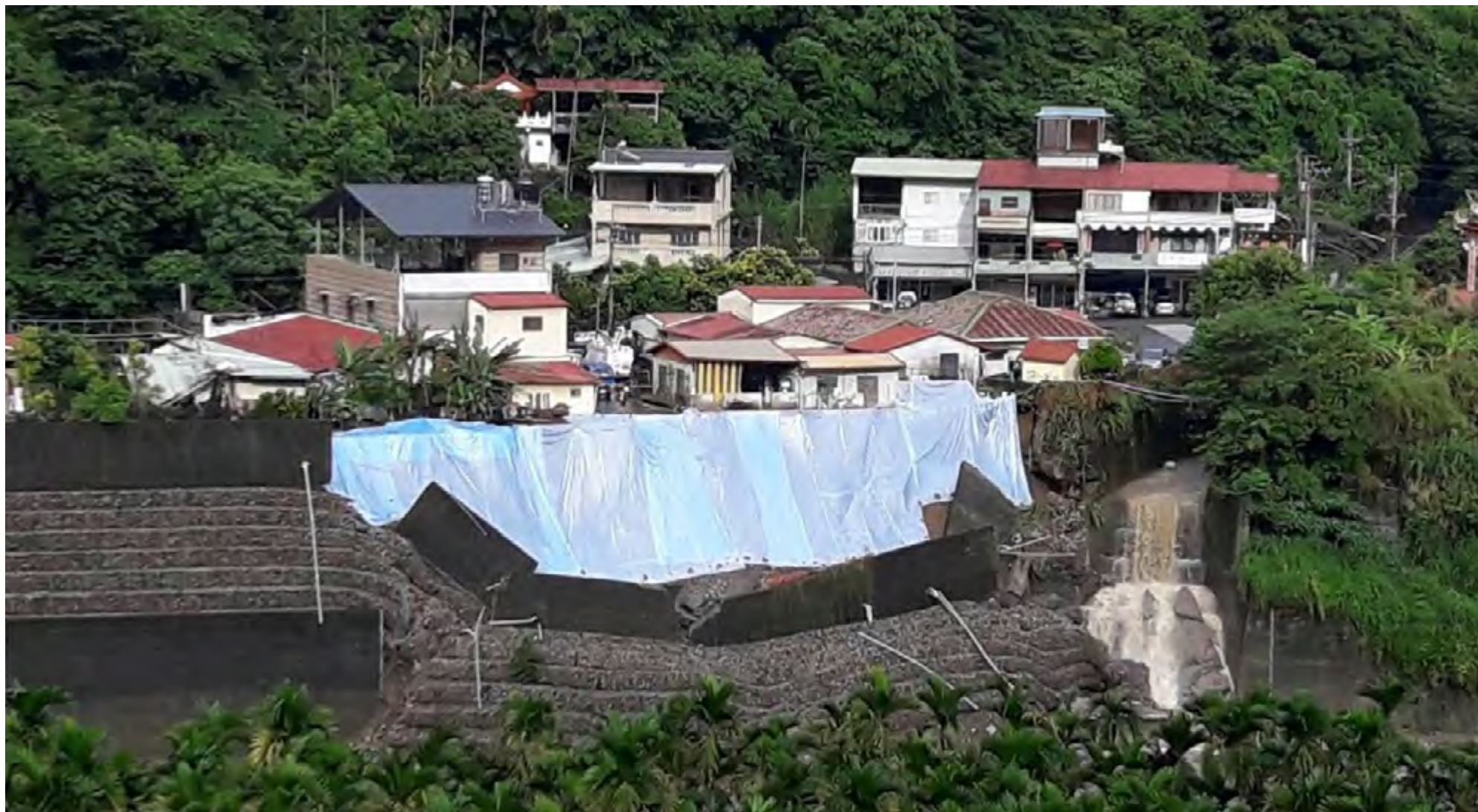
南投國姓鄉烏溪柑林河段護岸邊坡塌陷 ( 資料來源：第三河川局 )
