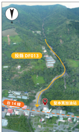
投縣 DF013 災後情形 (資料來源：災防科技中心)
