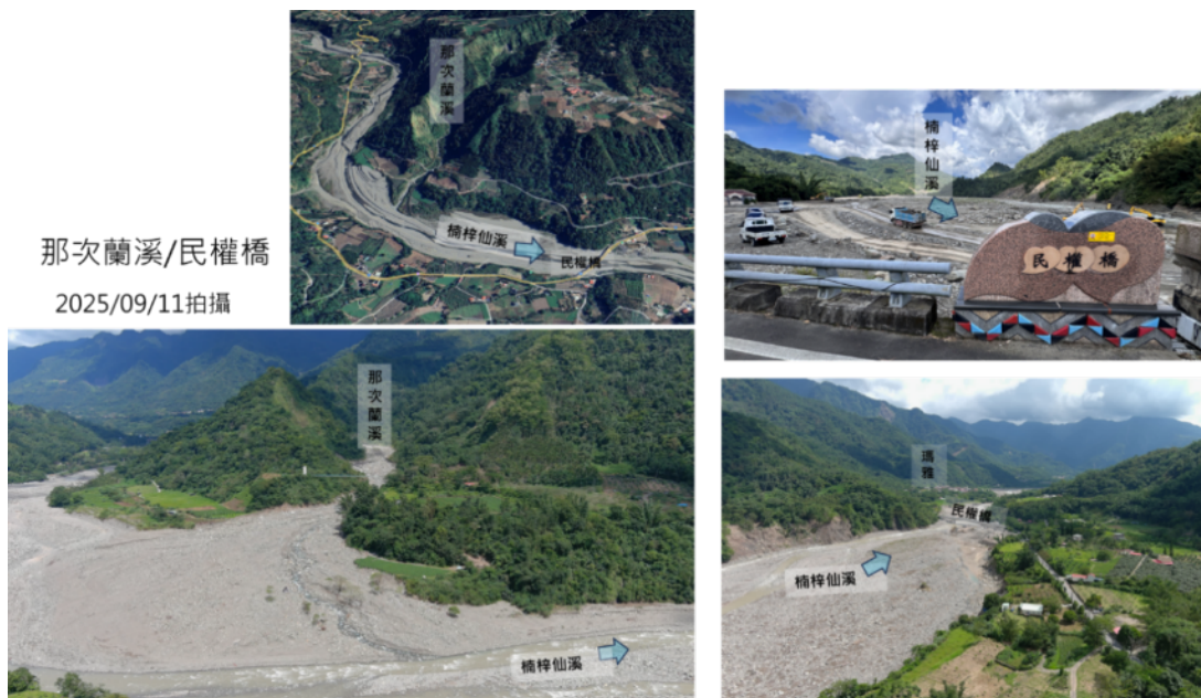
(b)那次蘭溪土石流出扇狀堆積擠壓旗山溪(楠梓仙溪)，以及民權橋疏濬工程
