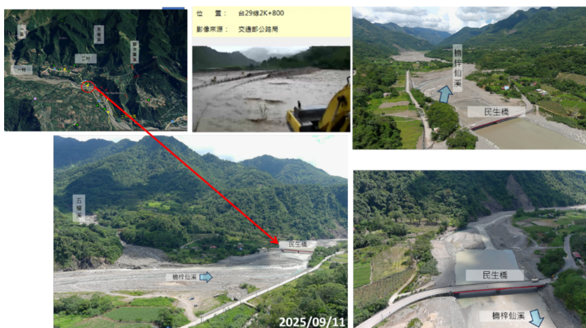
圖 3.2.3、楠梓仙溪淹沒民生大橋 CCTV 與災後空拍現況
