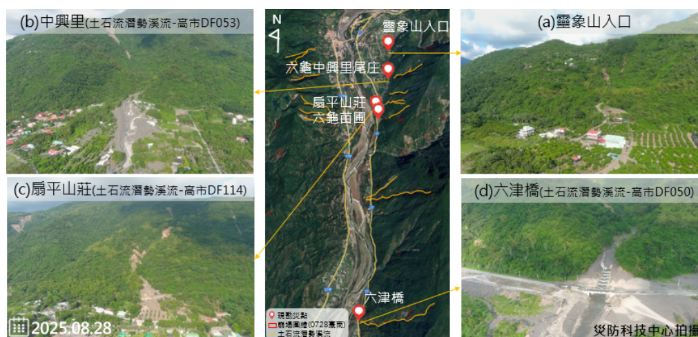
圖 3.2.14、荖濃溪六龜區現勘點位分佈和災害影像(資料來源：農村 水保署；製圖：災防科技中心)
