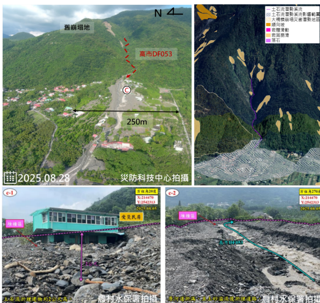
圖 3.2.16、土石流潛勢溪流(高市 DF053)災害影像與(左上)與災害潛勢(右上)與災害地面照片(下)(資料來源：農村水保署[18]、3D 災害潛勢地圖；製圖：災防科技中心)
