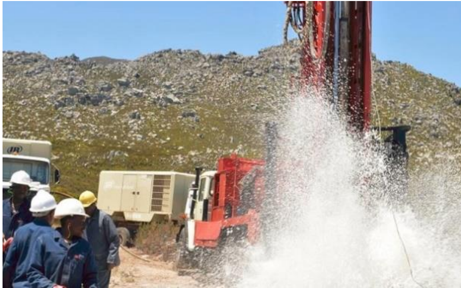
圖 13、開普敦市長視察地下水鑽井測試（圖片來源：City of Cape Town） [5]
