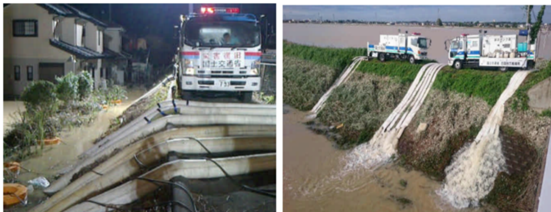
圖 94. 災中、後排水作業 (日本國土交通省關東地方整備局)
