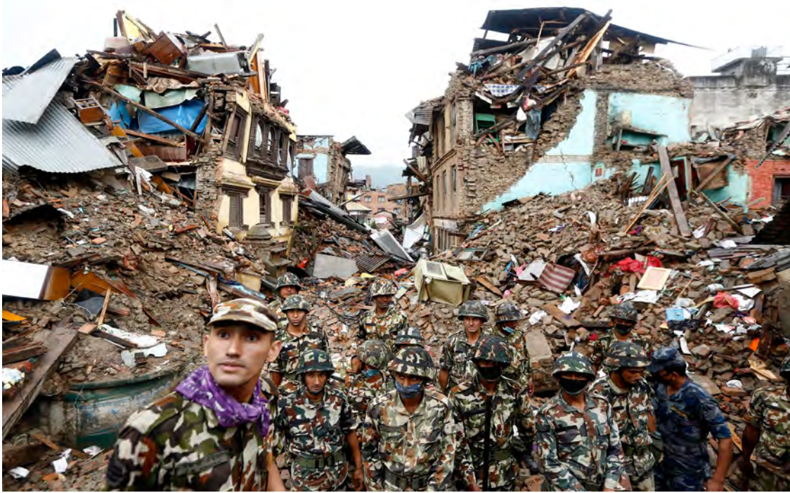
軍隊在耐震不足建物中，找尋生還者。照片來源：歐新社
