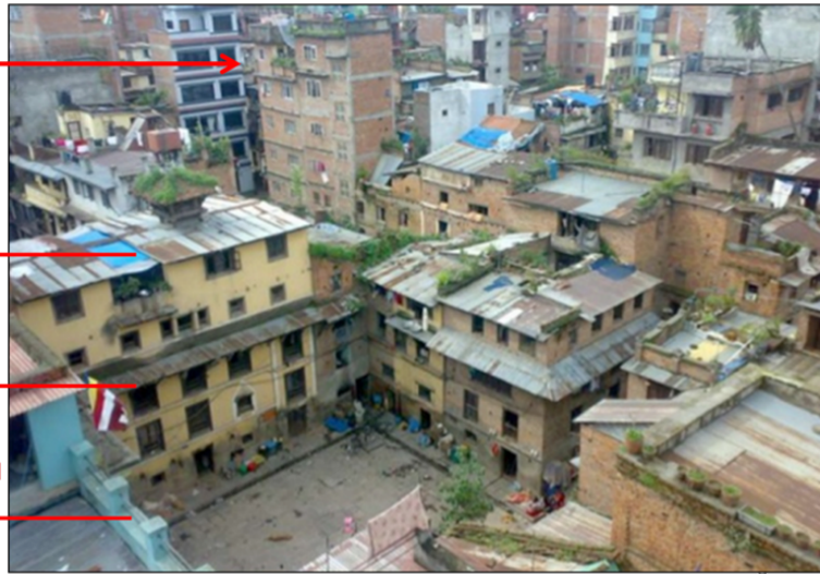
圖 12. 加德滿都仍有大量「房舍疊加（老摺少）」結構型態之建物
