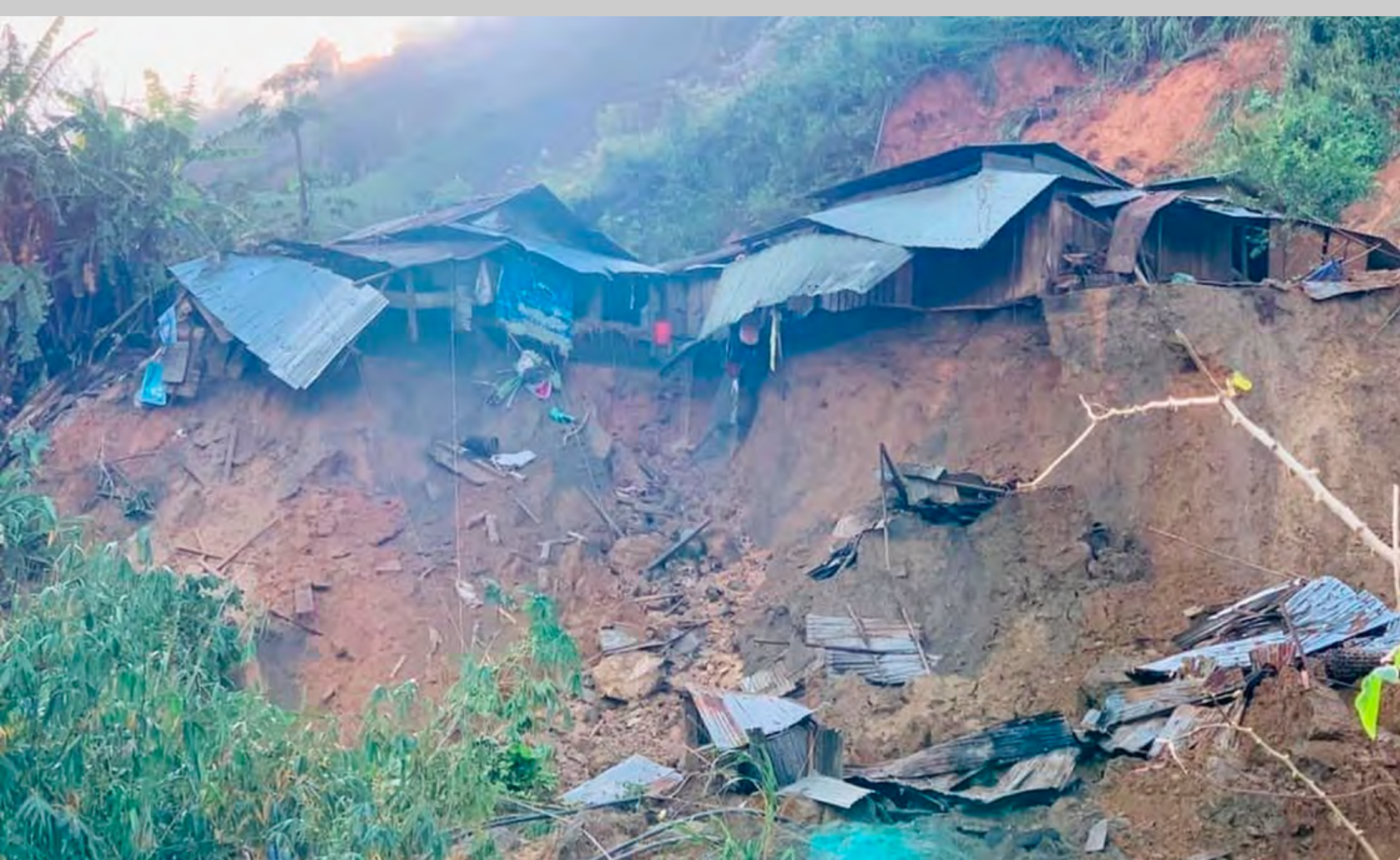
2020 年 10 月 29 日在越南廣南省 Phuoc Loc 地區一處村莊發生邊坡崩塌，造成數棟房屋損壞與人員傷亡（資料來源：AP/ 達志影像授權提供）
