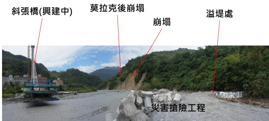
圖 6 溢堤處災後照片(拍攝日期：9/24)
