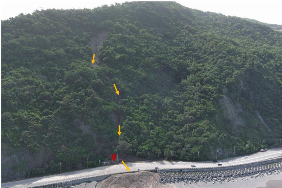
圖 6.1.7、台 9 線 405.1k 路段現勘照片(資料來源：災防科技中心 2025/07/24 攝)
