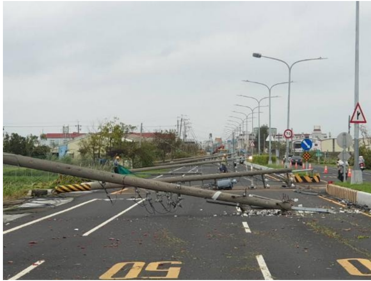
圖 2.3.4、丹娜絲颱風重創嘉南平原，使電桿整排倒斷
