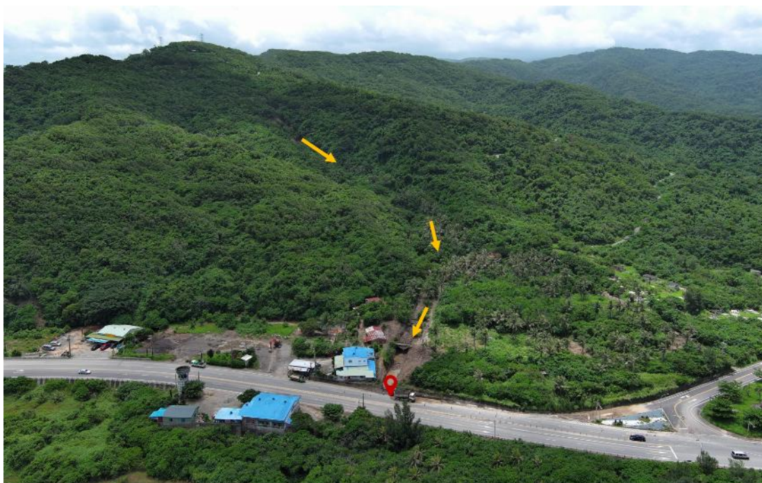
圖 6.1.14、台 9 線 425k+100 路段現勘照片(資料來源：災防科技中心 2025/07/24 攝)
