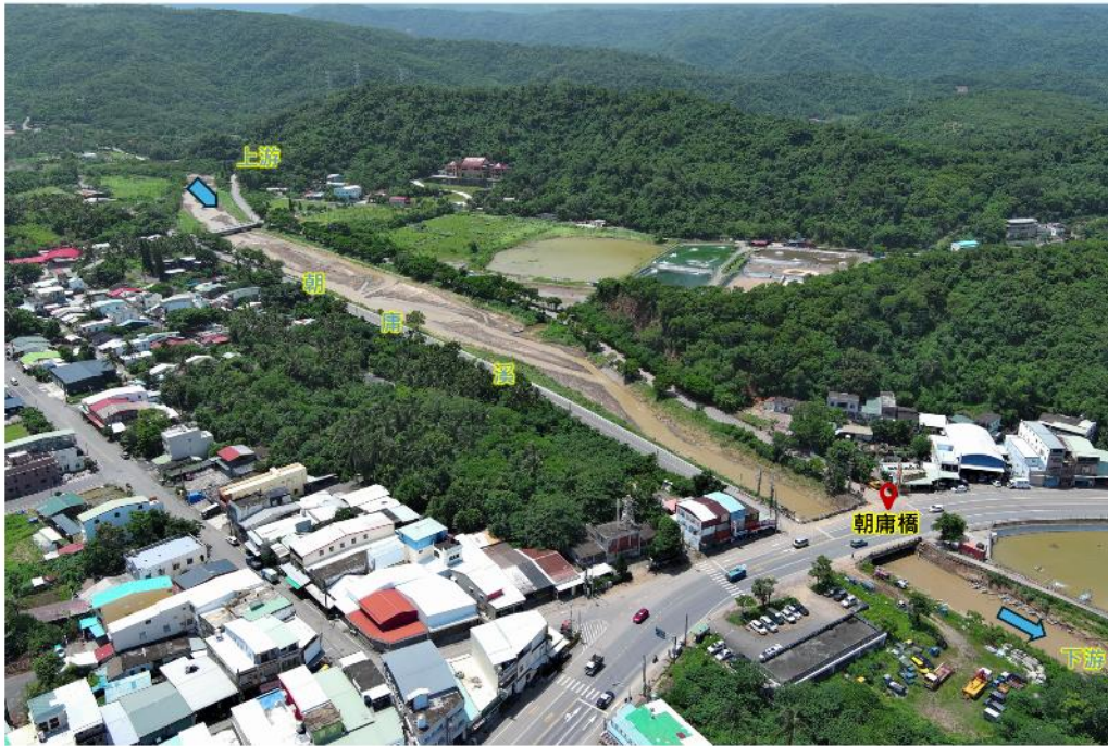
圖 6.1.11、朝庸橋路段現勘照片(資料來源：災防科技中心 2025/07/24 攝)
