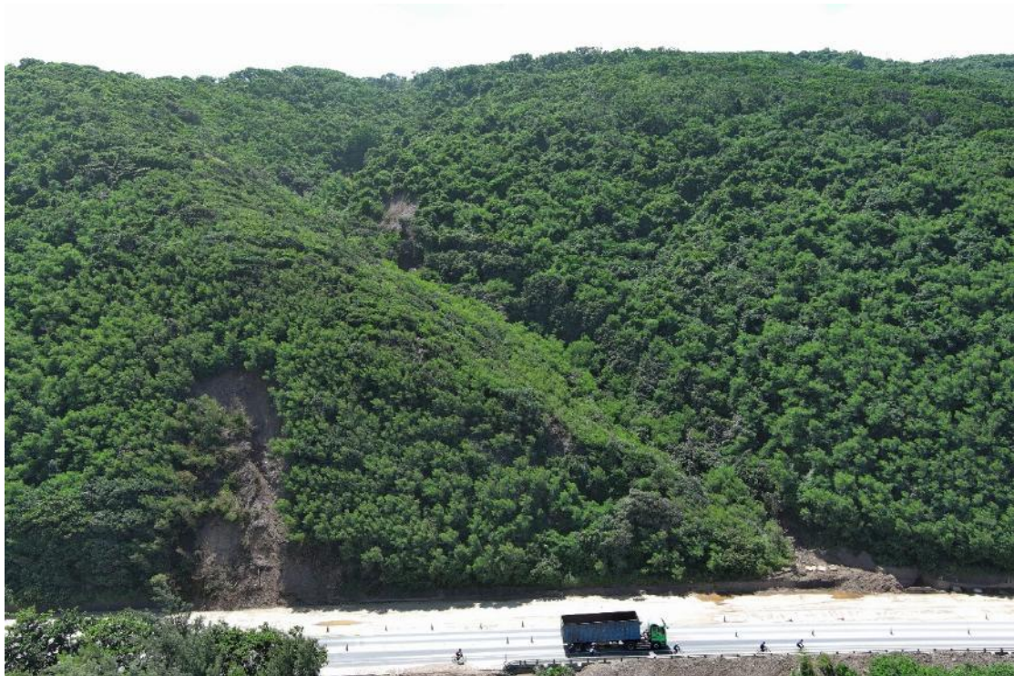
圖 6.1.3、台 9 線 417.1K 路段現勘照片(資料來源：災防科技中心 2025/07/24 攝)
