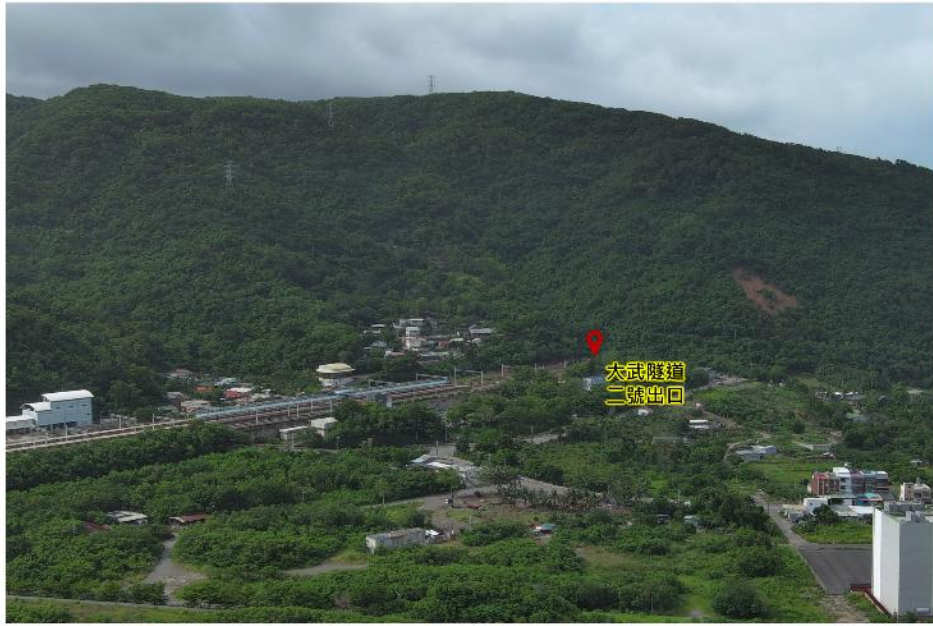
圖 6.1.18、大武隧道二號出口調查照片(資料來源：災防科技中心 2025/07/24 攝)
