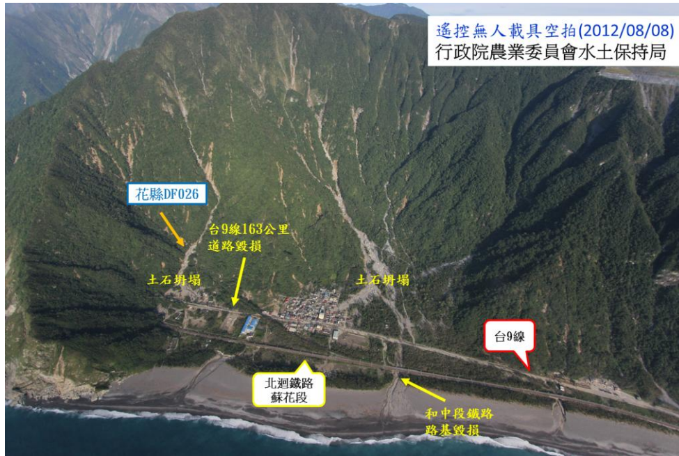
圖 10 和中地區空拍影像（資料來源：農委會水土保持局）
