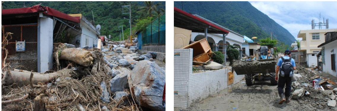
圖 12 民宅堆積土石堆積狀況
