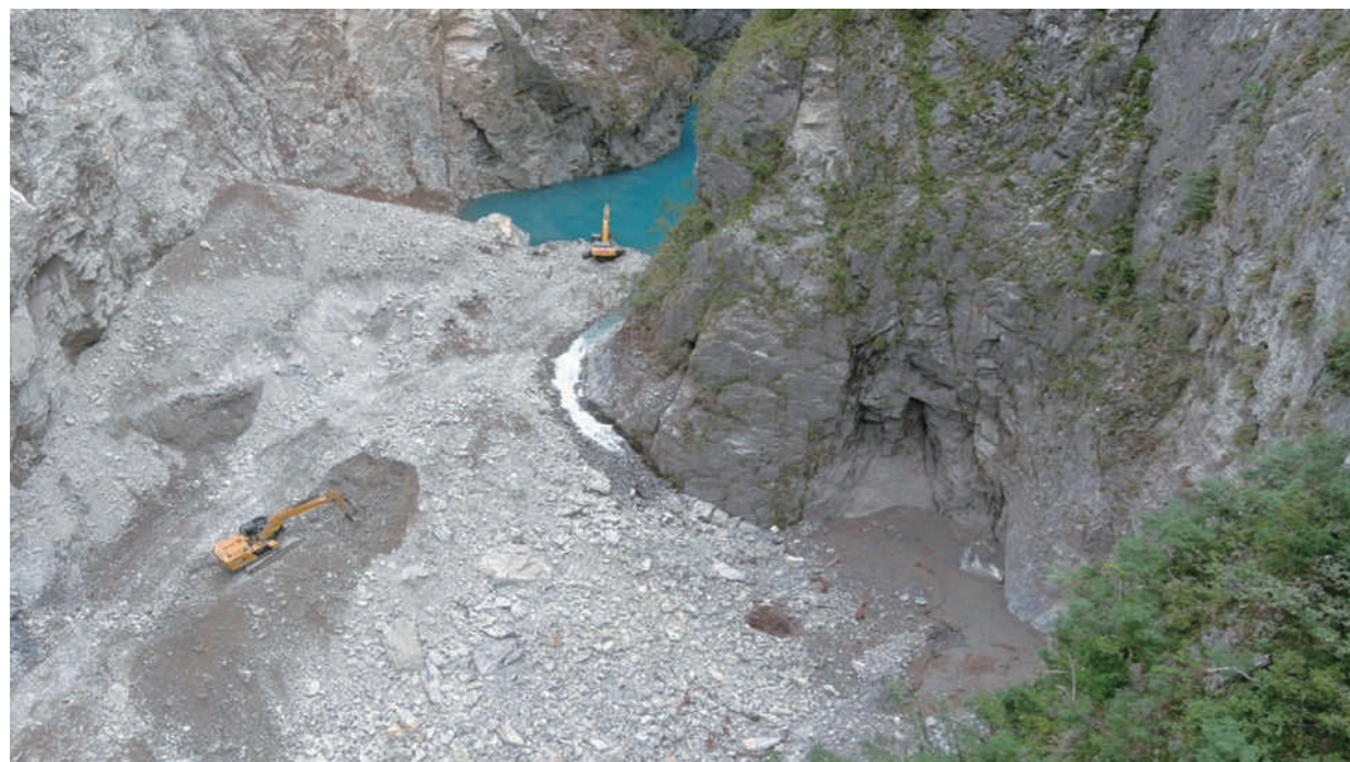
2025 年 10 月 26 日機具進行降挖引流工程 (資料來源：太魯閣國家公園管理處)
