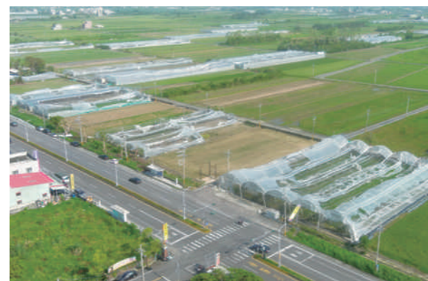
丹娜絲颱風造成嘉義縣農業設施結構變形毀損(資料來源：災防科技中心)
