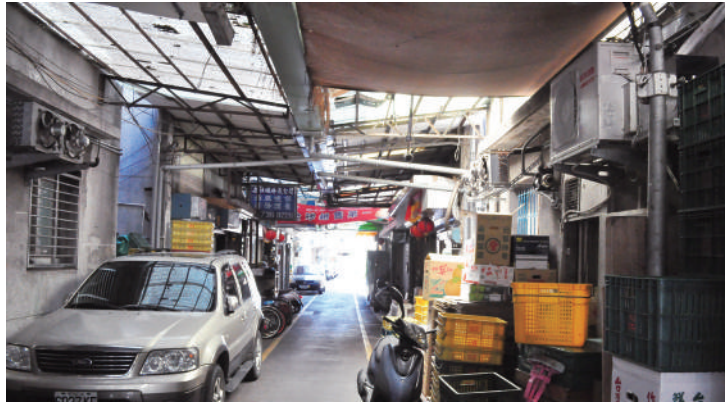
▲ 萬一發生震後火災，低矮棚架容易造成延燒，阻礙救災行動。
