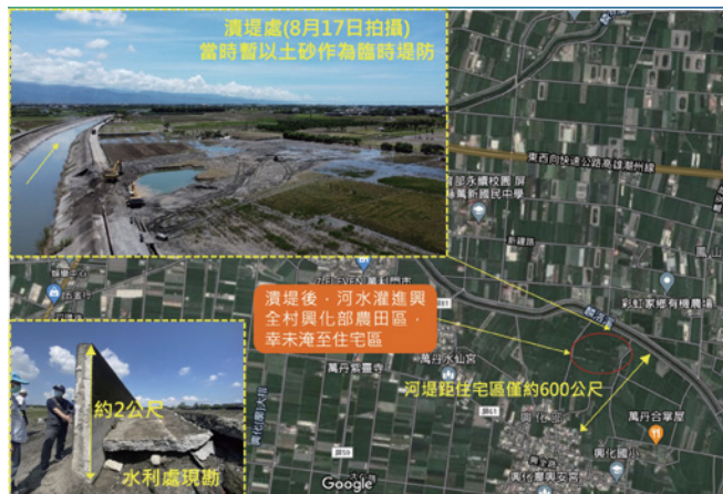
麟洛溪堤防潰堤位置示意圖（資料來源：災防科技中心）
