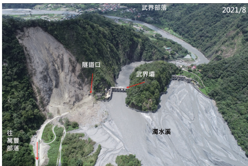
武界崩塌地周邊空拍（資料來源：災防科技中心）
