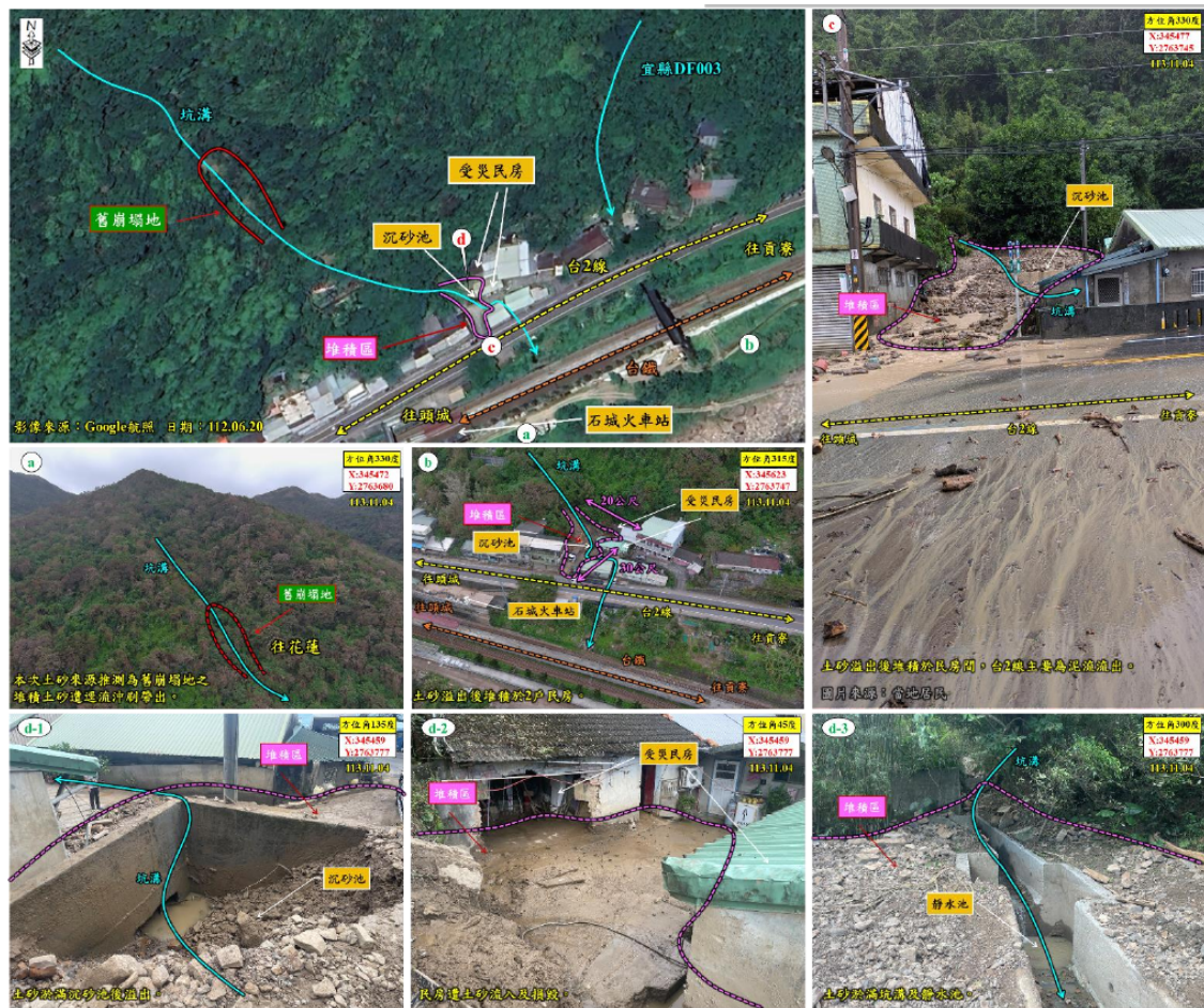
圖 3.2.3、康芮颱風台 2 線 116K 處土石流災害照片(資料來源：農村水保署 [6] )
