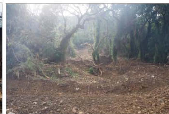
崩塌上游，下緣仍有部分植生
