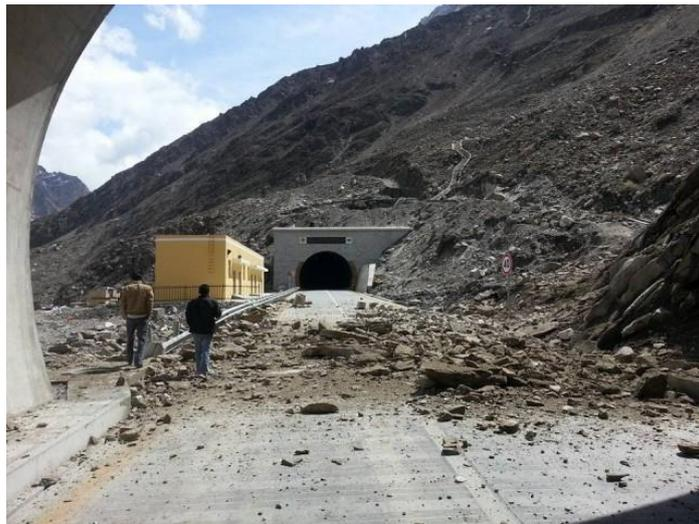
圖 13、崩塌阻斷 Attabad 隧道出入口（資料來源: Pamir Times）
