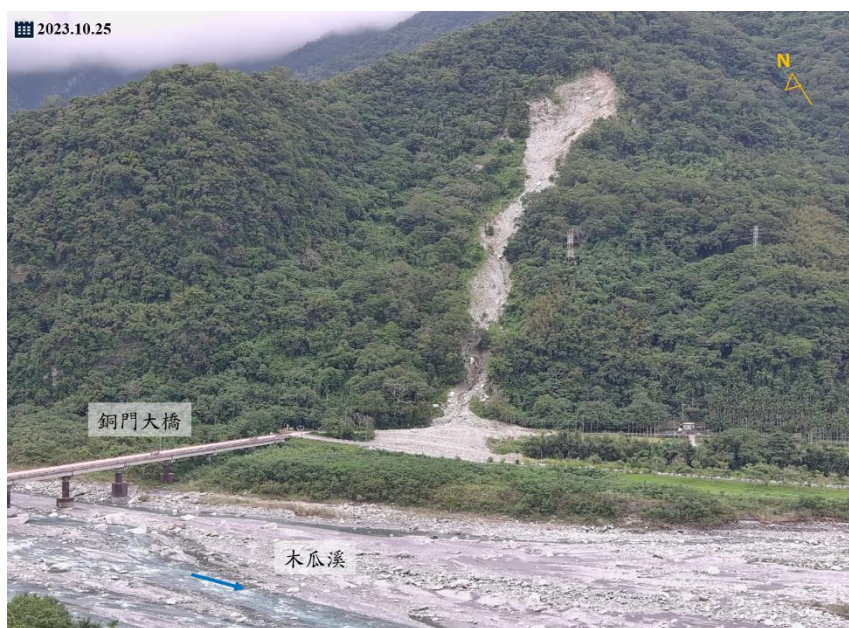
圖 3.17、榕樹部落往銅門大橋旁邊坡崩塌空拍影像(圖片來源：災防科技中心)
