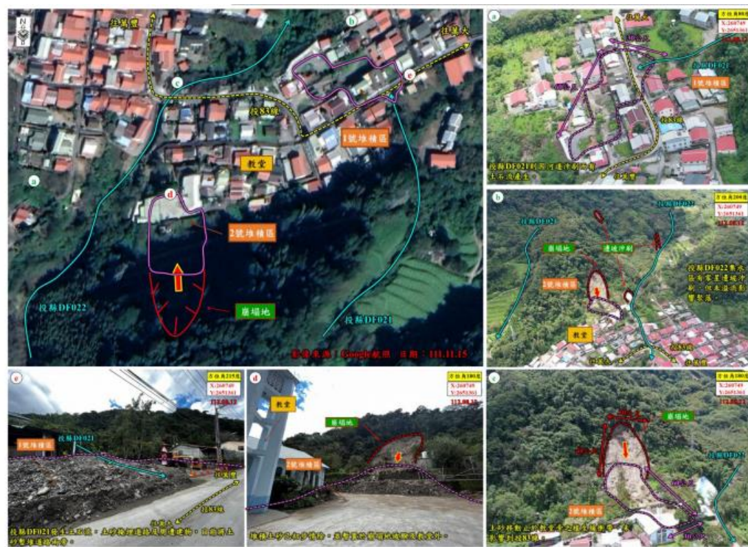
圖 4.16、投 83 線教堂上邊坡崩塌、土石流(資料來源：農村水保署)
