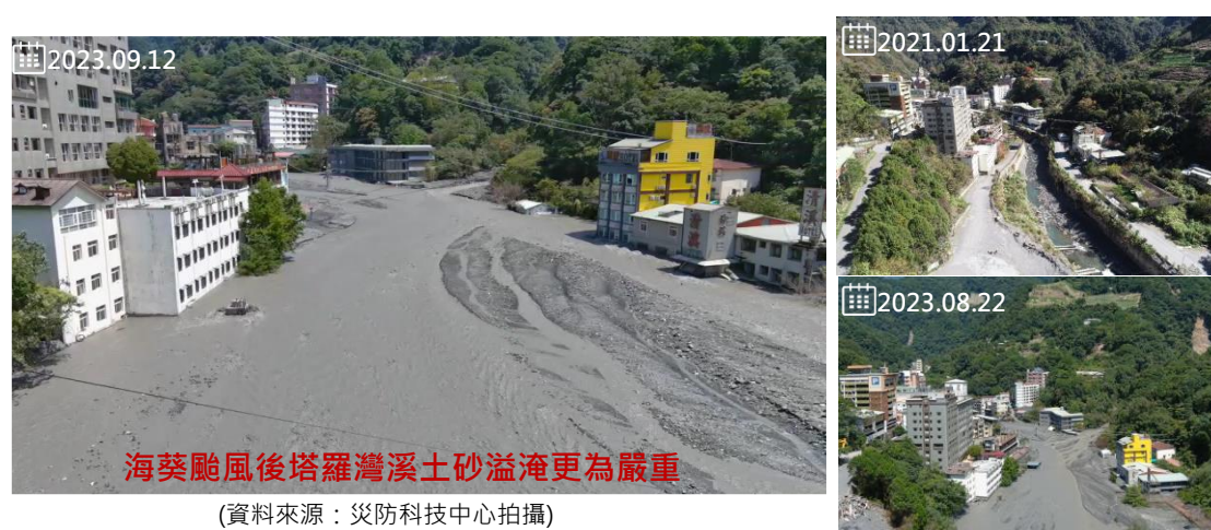
圖 6.13、海葵颱風災後南投縣仁愛鄉廬山溫泉區淤積情形
