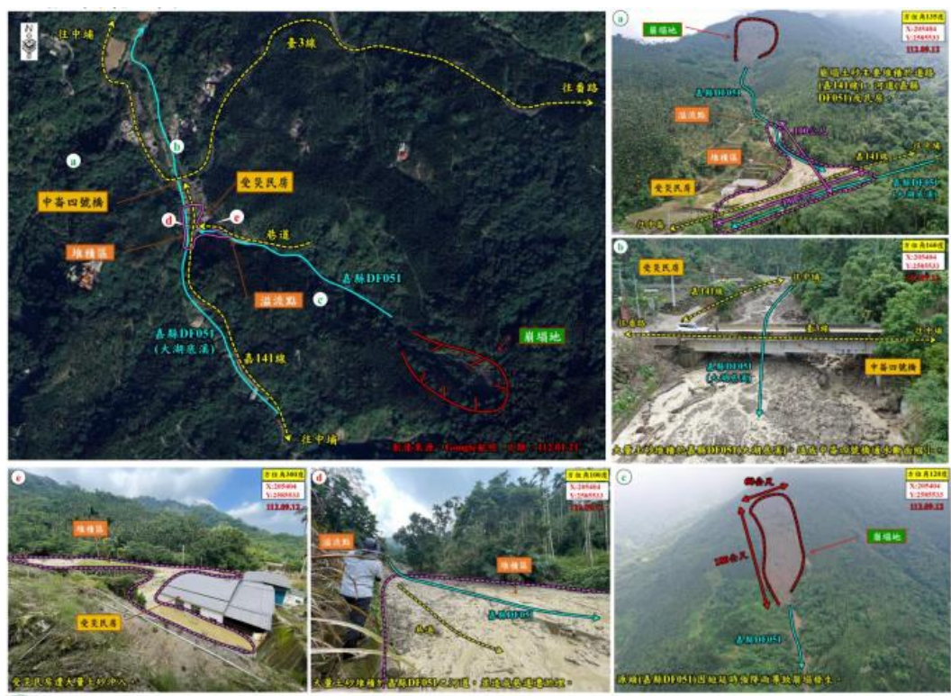
圖 7.4、台 3 線 300.9K 中崙四號橋(嘉縣 DF051)源頭崩塌(資料來源：農村水保署)
