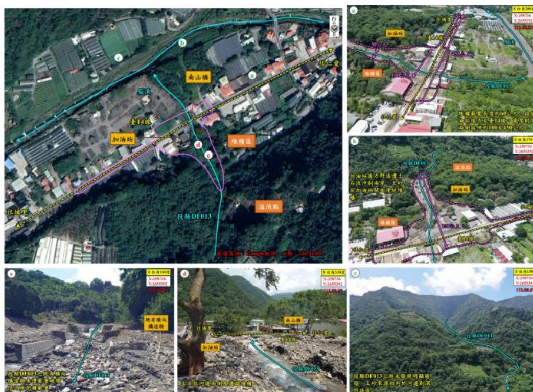
圖 4.11、台 14 線 71K 之聖本篤加油站(投縣 DF013)土石流(資料來源：農村水保署)
