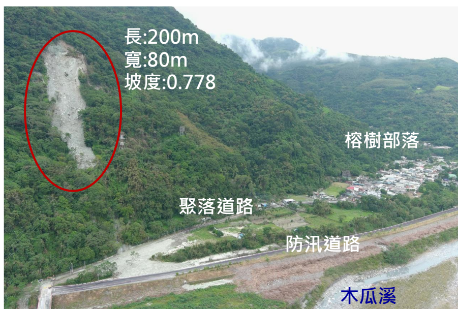
圖 3.16、2021 年圓規颱風過後榕樹部落與崩塌地空拍影像(圖片來源：災防科技中心)
