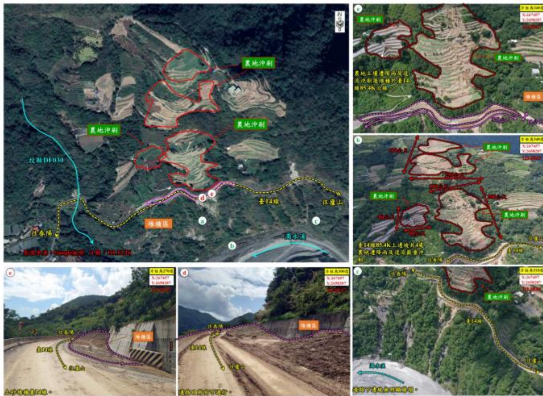
圖 4.15、臺 14 線 85.4K 崩塌(資料來源：農村水保署)
