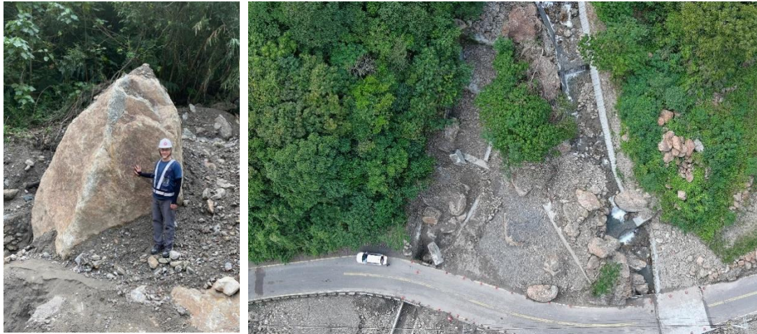
圖 6.20、碧侯溫泉聯外道路崩塌岩屑粒徑之現場與空拍近照(資料來源：災防科技中心)
