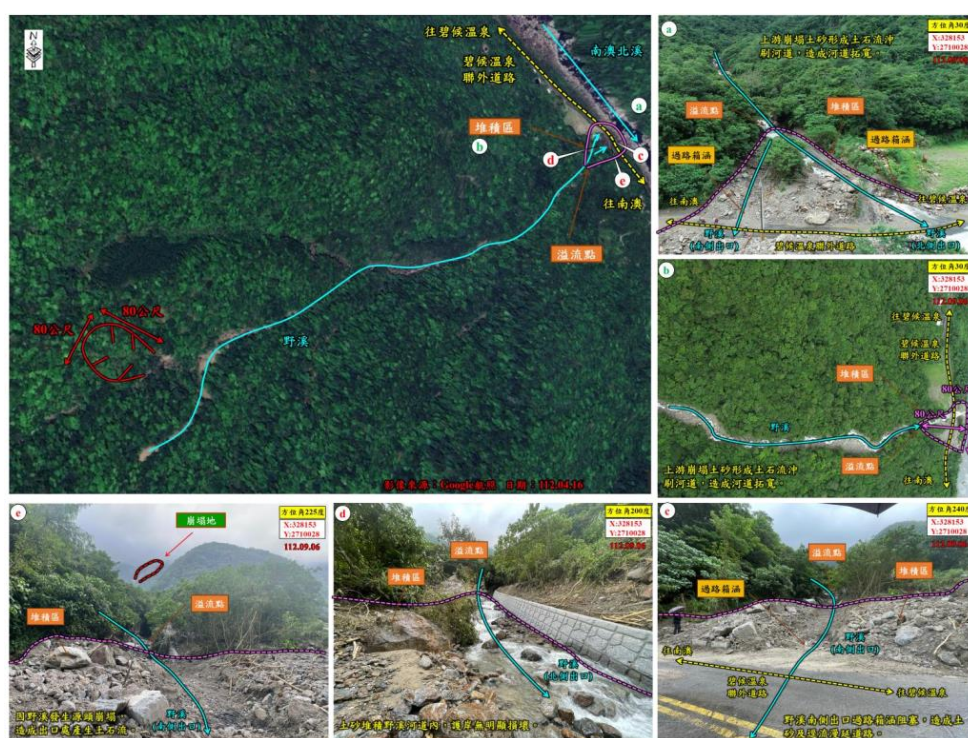
圖 6.17、碧侯溫泉聯外道路崩塌情形(資料來源：農村水保署)
