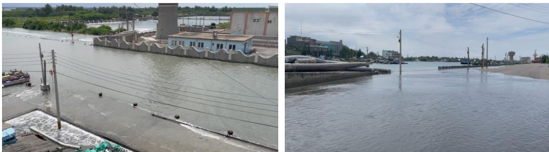
圖 5.12、港區周邊道路 9 月 1 日溢淹情形(資料來源：安檢所同仁)
