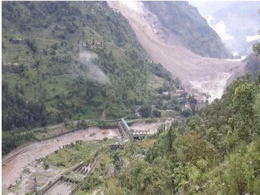
圖 8 山崩所造成之堰塞壩 (照片來源：尼泊爾政府網站)
