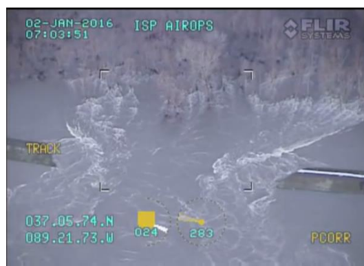
(b)伊利諾州南邊河堤潰堤
