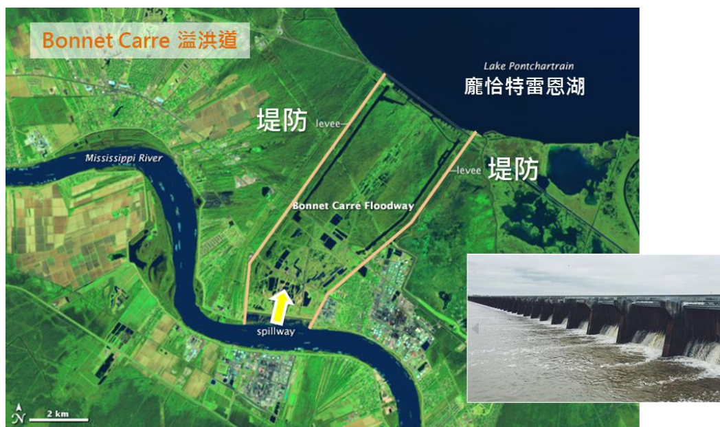
圖 10 Bonnet Carre 溢洪道 7
