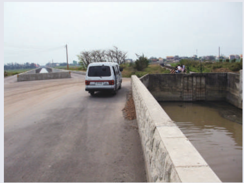
▼ 排水路徑多處直交彎折，將造成排水不順，容易發生溢淹之現象。
