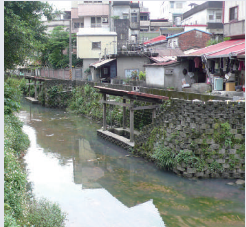
▲ 佔用行為皆會阻礙水流，因而抬升河川水位，增加洪水向兩岸社區溢淹的風險。
