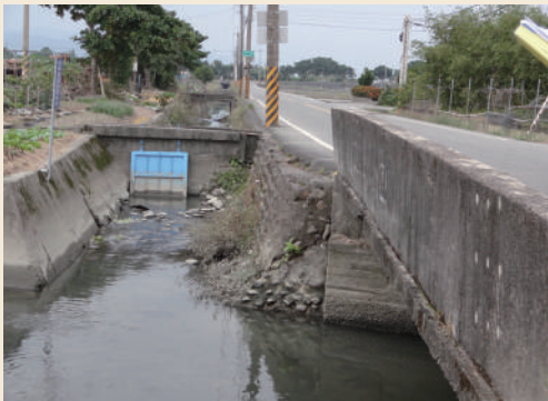
▲ 保持區域排水系統的通暢，避免淤積或阻塞情形產生，將可維持原先設計的排水功能。
