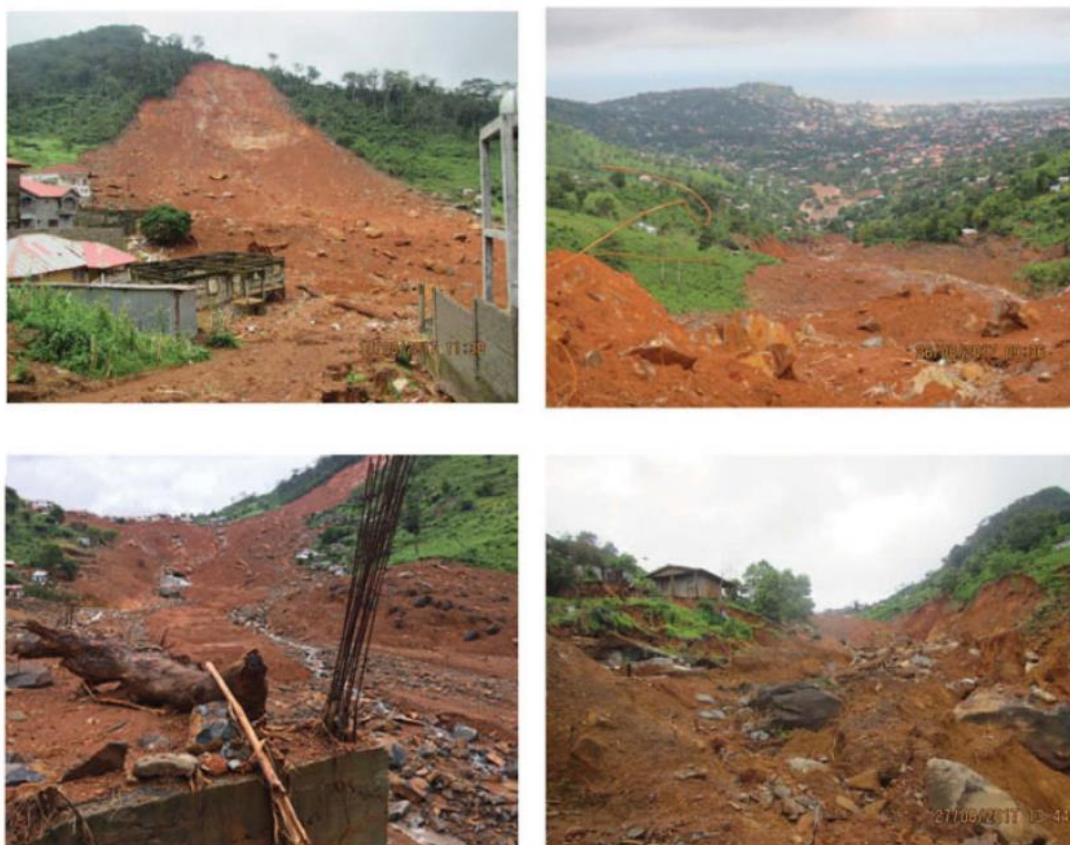
圖 8 雷鎮崩塌崩崖與進入溪流災害型態
