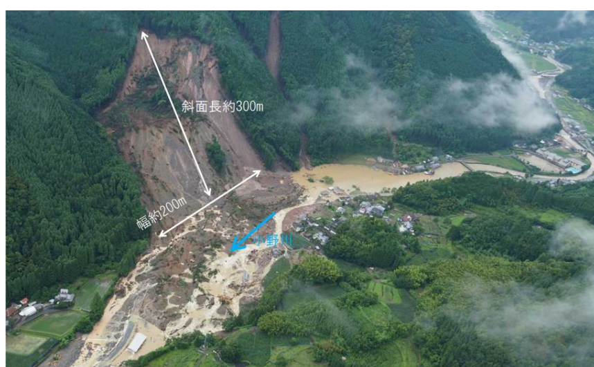
圖 10-大分縣日田市小野地區山坡地崩塌影像(資料來源：國土交通省九州地方整備局)
