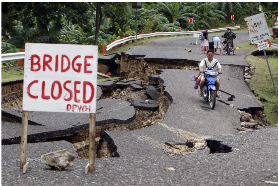
照片6-2 地震造成當地道路龜裂毀損，橋樑中斷。照片來源:歐新社
