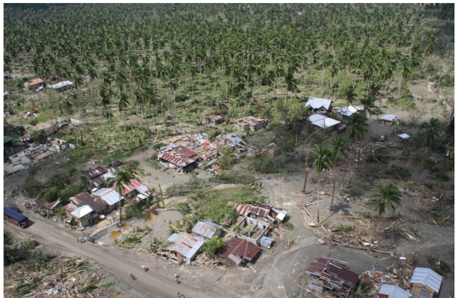
照片3-14 菲律賓當地房屋經不起寶發颱風強風吹襲毀損。
