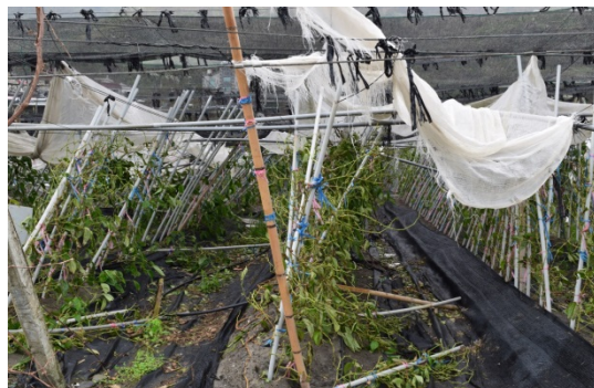
農業設施與荖葉受損情形
