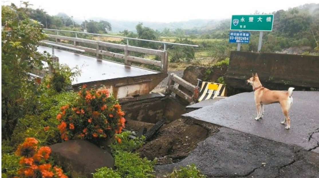
圖 24 台 23 線永豐大橋斷裂。(圖片來源：聯合新聞網，圖／花蓮富里鄉豐南社區發展協會藍姆路·卡造提供) [9]
