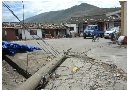
屋瓦損毀、電線杆倒塌
