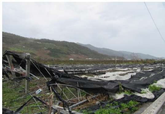
農業設施水平棚架受損情形
