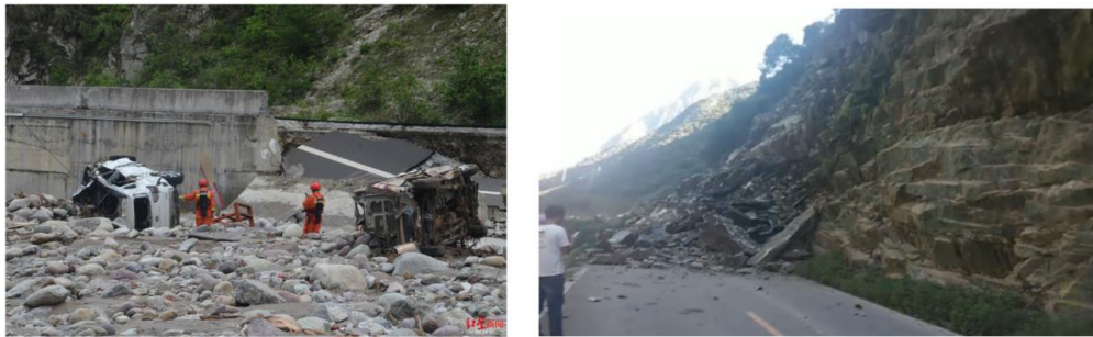
圖 13、冕寧高速路口 248 國道因路基流失，路面坍塌道路中斷 (資料來源：中國紅星新聞(左)、川報觀察(右))
