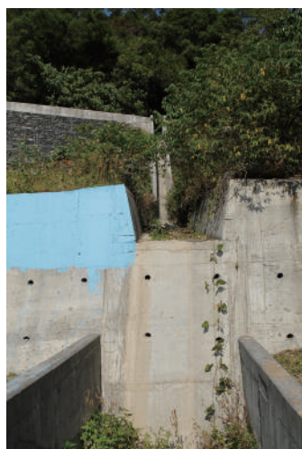
▲ 山區排水溝必需引導到區域排水系統內，才能避免地表逕流破壞邊坡。
