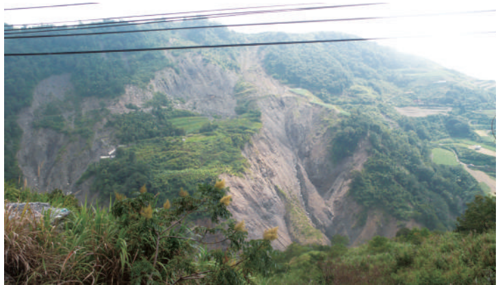
▲ 位於南投縣力行產業道路旁的舊崩積土坡，因土坡內部材料組成散，易受到降雨後而產生滑動，有時滑動後邊坡上方植生保留完整，且可明顯看出滑動塊體的原始位置。
