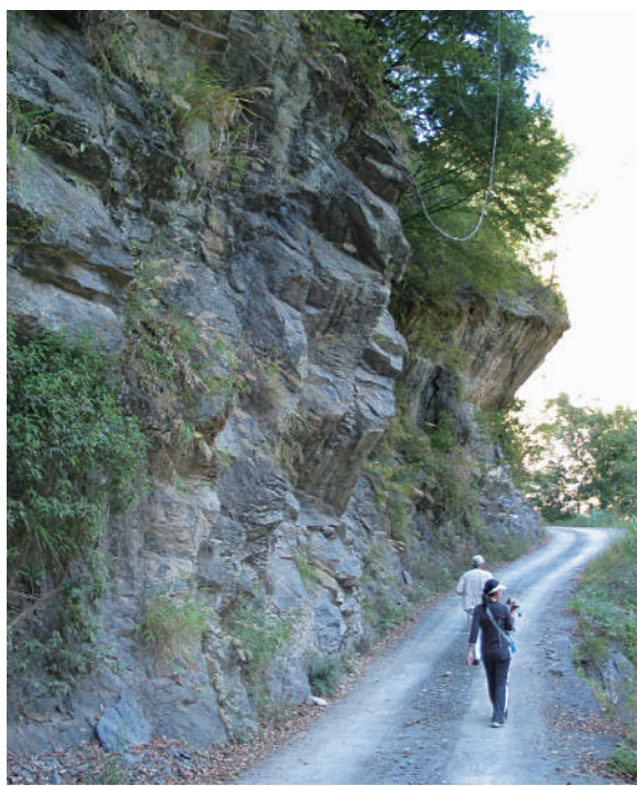
▲ 裸露峭壁地區容易發生落石災害。
