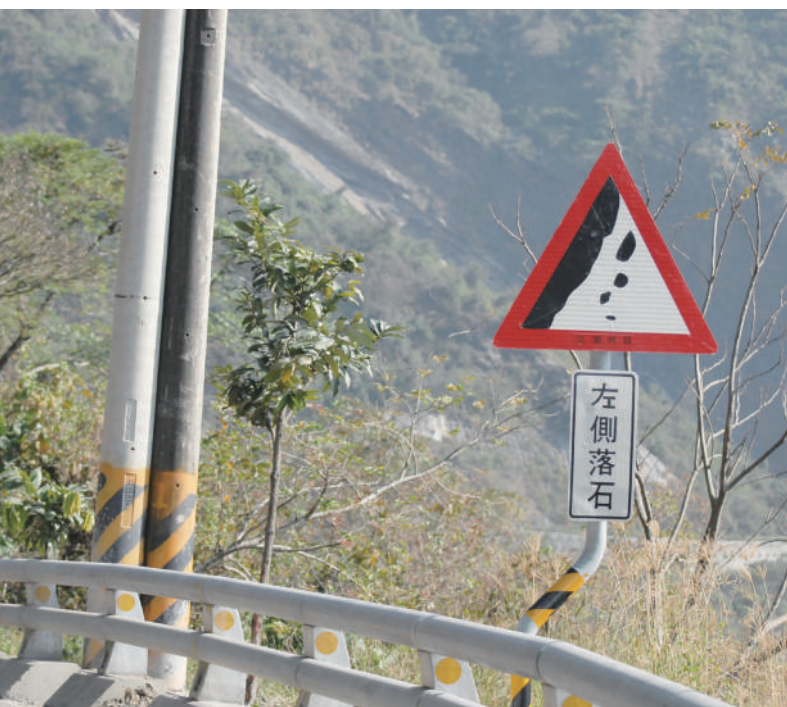
▲ 陡峭坡地附近常設置有注意落石的警示標誌。
