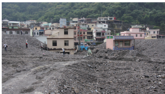
▶ 2010 年凡那比颱風期間，來社溪溪水與土砂越過堤防後，溢淹至屏東縣來義鄉來義村。
