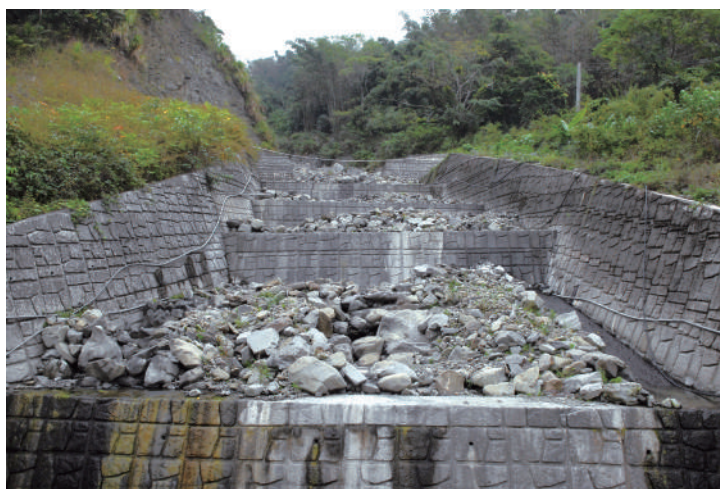
▲ 防砂壩是土石流攔阻工程中最常使用的工法之一。
