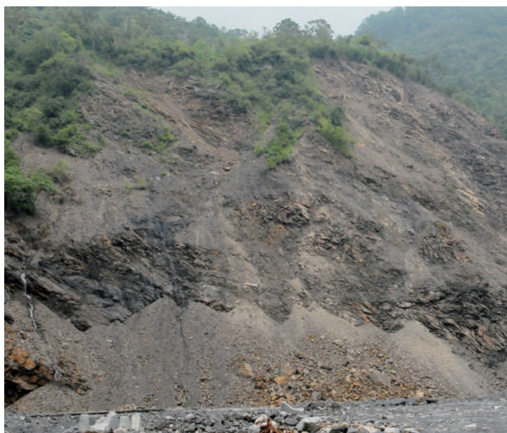
▲ 邊坡發生崩塌破壞時，土石會堆積在坡腳處。
