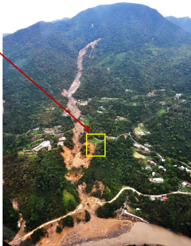
圖 16 忠治里崩塌處與危及電塔
