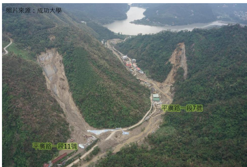
圖 23 平廣路一段 7 號~11 號空照圖
