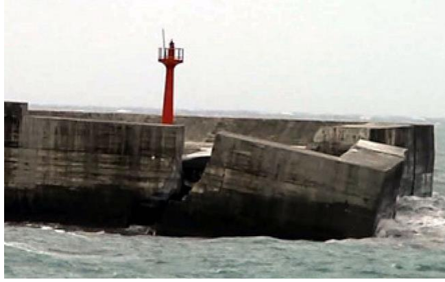
圖 35 基座斷裂、燈塔傾倒（東森新聞）
