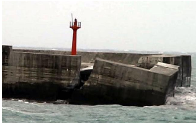
圖 35 基座斷裂、燈塔傾倒（東森新聞）
