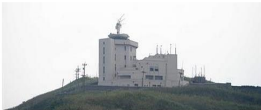
圖 38 天線罩破裂滾落（新聞圖片）
